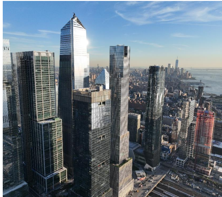
ハドソンヤード 全景
