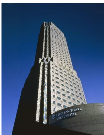
セルリアンタワー東急ホテル
