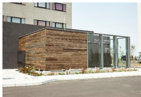
昨年まで稼働していた純水素型燃料電池
