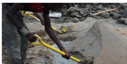
2022年7月 砂とセメントを混ぜて土台造り。
