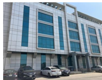
支店が入居する建物の外観
