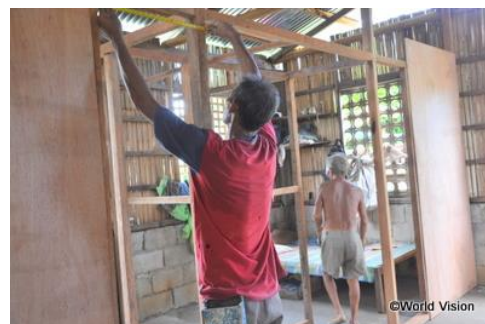
WVの支援で、住民自身の手によって新しい家の建設が進んでいます
