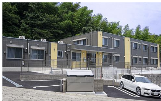
▲王禅寺グループホーム・王禅寺の宿（外観）
