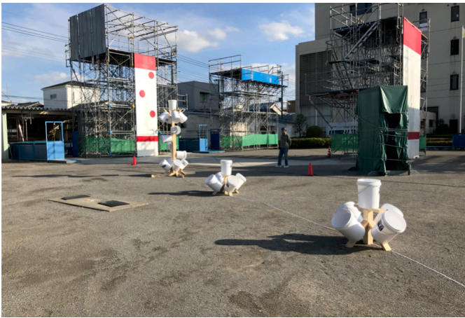
写真 機材設置状況
