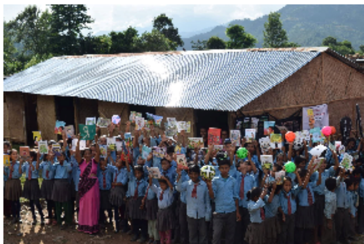
完成した仮校舎（ヌワコット郡）
