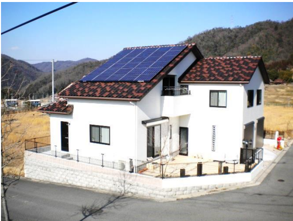
〈住宅用太陽光発電設置事例〉
