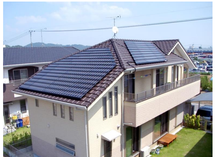
<住宅用太陽光発電システム 4.72kW>
