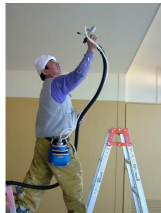
吹付作業風景
