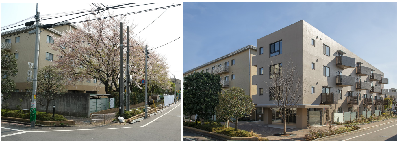
北西外観（左から、施工前、施工後）
