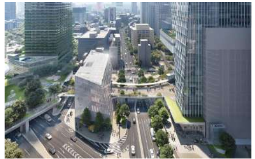
T-デッキ 桜田通り上にかかる広幅員の広場状の空間
