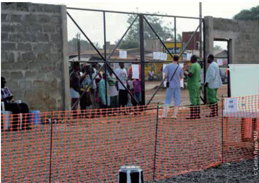
建築チームが世界最大のエボラ治療センターとなる ELWA-3(250床)の建設を進める(リベリア・首都モンロビア)
