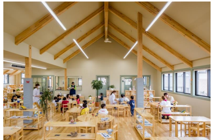
SE 構法物件 左：住宅／右：中大規模木造建築（保育園）
