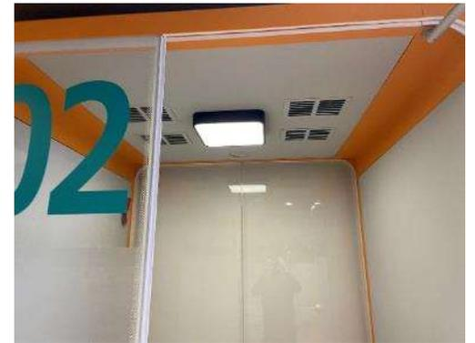
写真：内装不燃パネル設置事例（換気の為の開口部にスチール製カバー）
