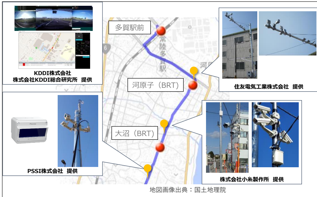
図 3. 路側センサーの設置個所と設置物
