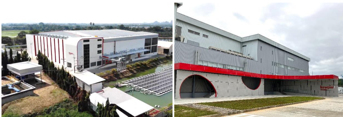
⑤キューピータイランド既存工場内の新棟、⑥キューピーインドネシア既存工場の増築部
