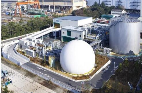
食品廃棄物を再生可能エネルギーに変える「バイオフードリサイクル」を導入しております。ホテルから出る食品廃棄物のリサイクル率 100%を実現すると共に、廃棄物を微生物によりメタン発酵させることで発生したバイオガスで、ガスエンジンを動かし、発電するという取り組みへ参画。さらにその電気を購入することで、「地域循環型エネルギーの利活用」の仕組みを確立いたしました。
