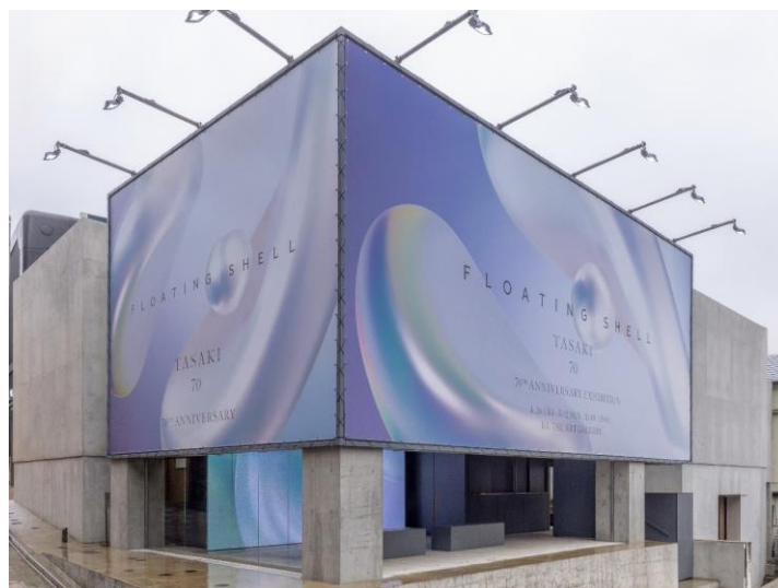
StandBy 外観 ©TASAKI
