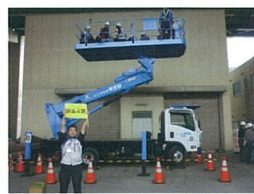
橋梁点検デモ
