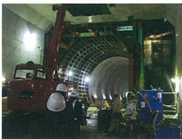
シールドトンネルの工事現場
