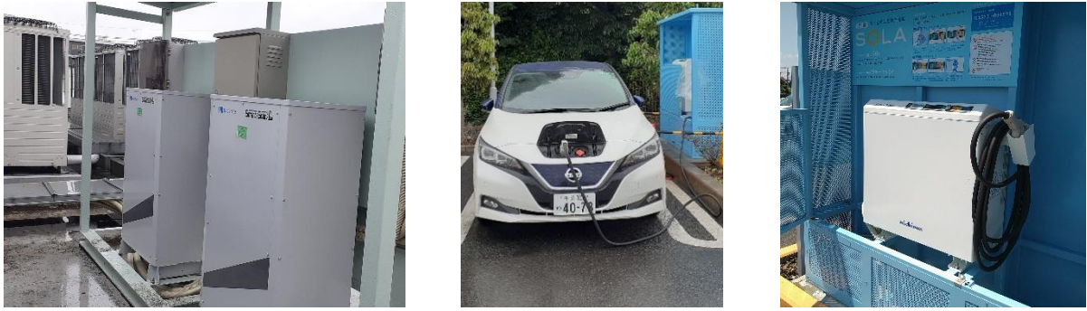
図3: AI・IoTにより電力の制御を行う蓄電池(左写真)、EV・V2H(中央写真・右写真)
