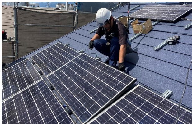
安全第一の工事を行う様子
