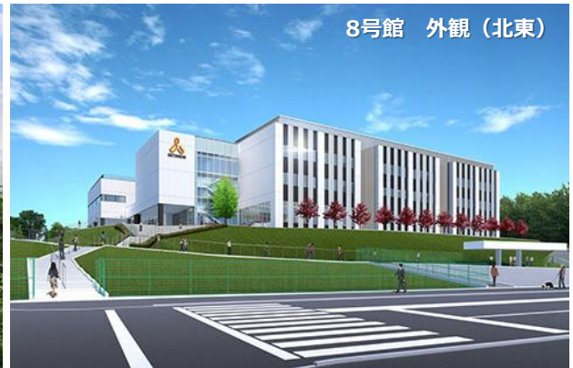
8号館 イーストゲートプラザ
