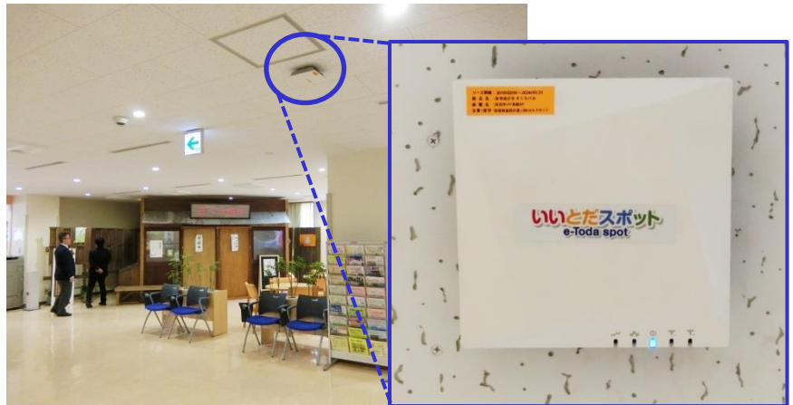
戸田市内のコミュニティセンター「さくらパル」に設置されたアクセスポイント
