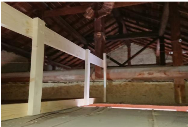
<屋根裏 (工事中 before) >
