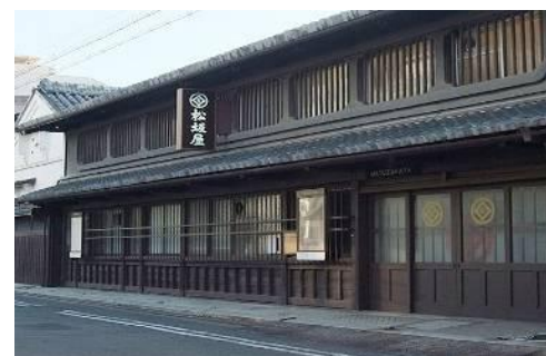
旧松坂屋京都仕入店建物 (明治 36 年築)
