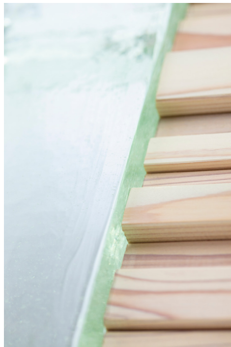
カウンターに使用する再生ガラスと、六甲の森の間伐した杉材
