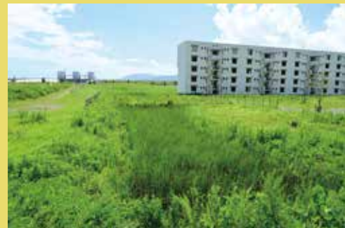
水生植物プール
