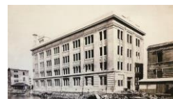
1923年（大正12年）築の元第一銀行の建物です。西洋建築の様式を多く取り入れ、当時としては最先端の技術が用いられた。
