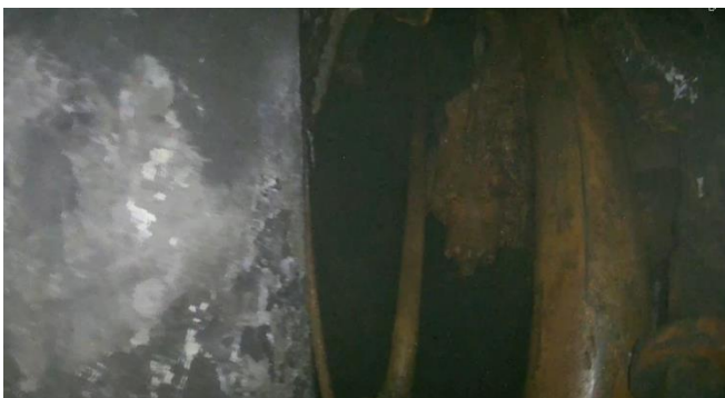
CRD 交換用開口部付近の様子(ペDESTAL外から撮影)
