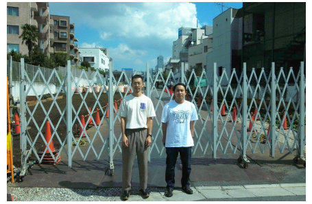
K2の入居する「(tefu) lounge」施工中の様子を背景に（左：北原 / 右：大高）
