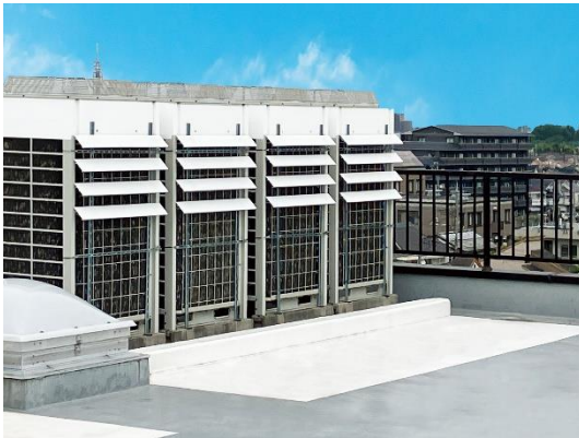
左：一般的な屋上のエアコン室外機の写真。室外機と周辺の床に遮熱塗料を塗装している。（白い部分）
