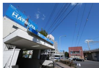
▲地下鉄亀島駅
