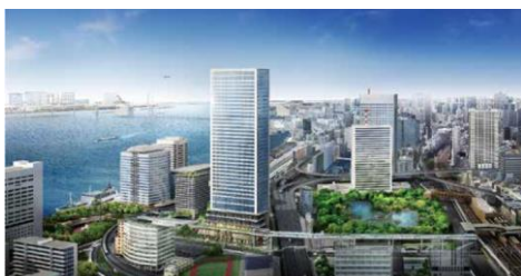
◀新交通ゆりかもめ・竹芝駅 西側に広がる約1.5haのエリアで進行中。A街区・B街区で、 オフィスや店舗、共同住宅、保育所などが整備される。 （画像提供／東急不動産）
