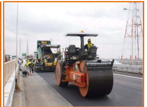
【アスファルト舗装施工状況※】
