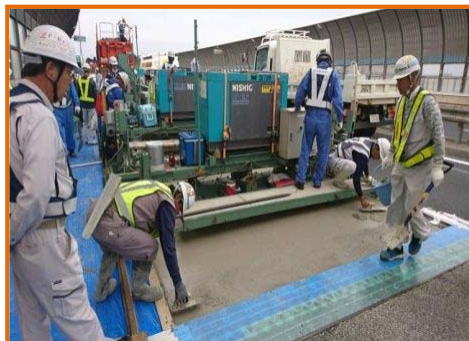
【鋼繊維補強コンクリート打設状況※】
