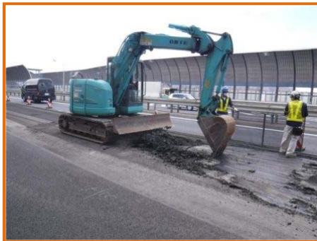
【アスファルト舗装はぎ取り状況※】
