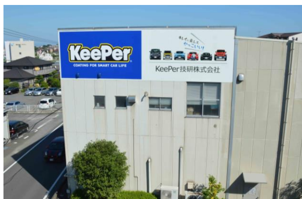
▲ 施工された本社看板
