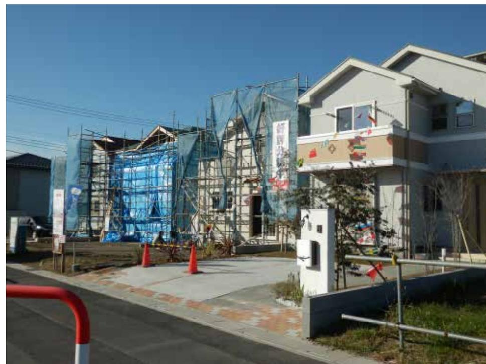
「ハイブリッドユニット工法」は、木造軸組在来工法でありながら枠組み工法を取り入れて、サッシや断熱材を組み込んだ大型パネルを工場生産する工法。最短一日で、屋根ルーフィング、サッシ取付け、断熱施工、間仕切り壁下地まで施工完了することができ、玄関も取付けられるため上棟後の躯体侵入も防ぐことができる。6月、11月に3躯体の実験棟を上棟し、約300名の見学者があった。本工法の特長は職人不足や高齢化に対応できるほか、太い柱や梁を使う在来工法の安心感そのままにユニット精度1ミリ程度の高い精度を持った高性能な木造住宅が完成する。この高い精度により梁や柱の現しや真壁工法も簡単に対応が可能のため国産材を利用した特色ある住宅造りが可能となる。両社では、工務店の販売、管理支援システムと合わせて全国の地域工務店へ販売を予定しており、希望する中小企業の地域工務店を募集する。
