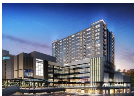
あかり舎（建物右側）
