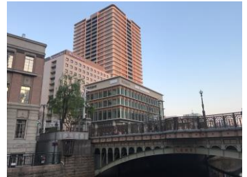
「テラッセ納屋橋」外観
