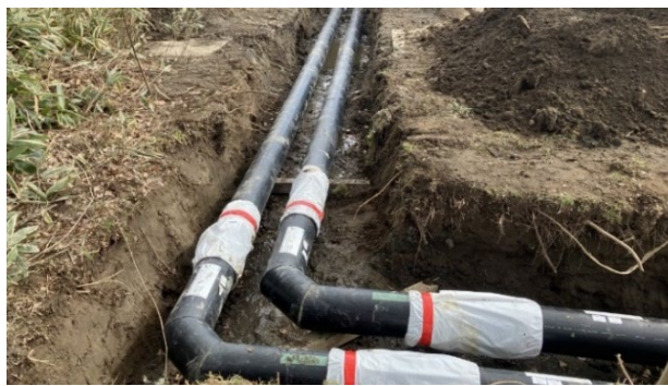
村内約3.5kmにわたる熱導管（現在は地中に埋設済）
