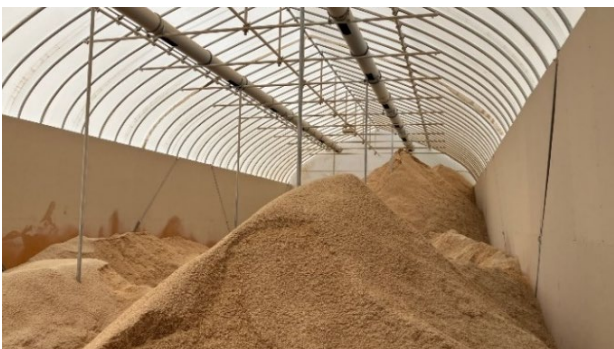
もみ殻貯蔵・搬送ハウス
