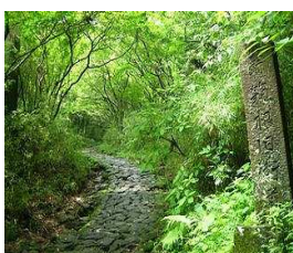
雨水がはけるよう計算された旧東海道石畳
