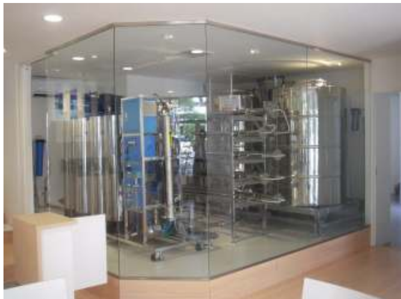
» 「みずはのめ」製造プラント
