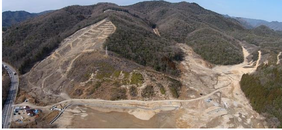
2015年/2月 工事開始前
