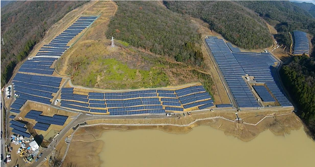
2015年/12月 太陽電池モジュール設置完了
