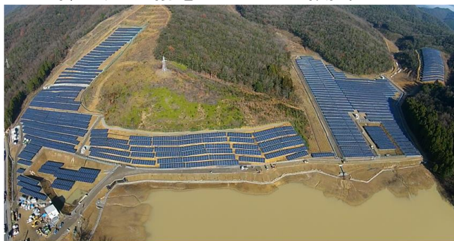
2015年/12月 太陽電池モジュール設置完了
