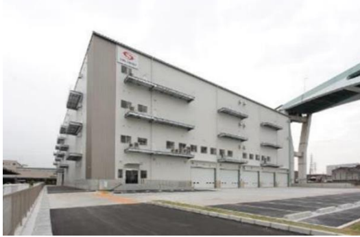
▲大阪物流センター 外観
