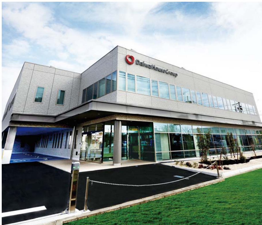
【大和ハウス佐賀ビル】
