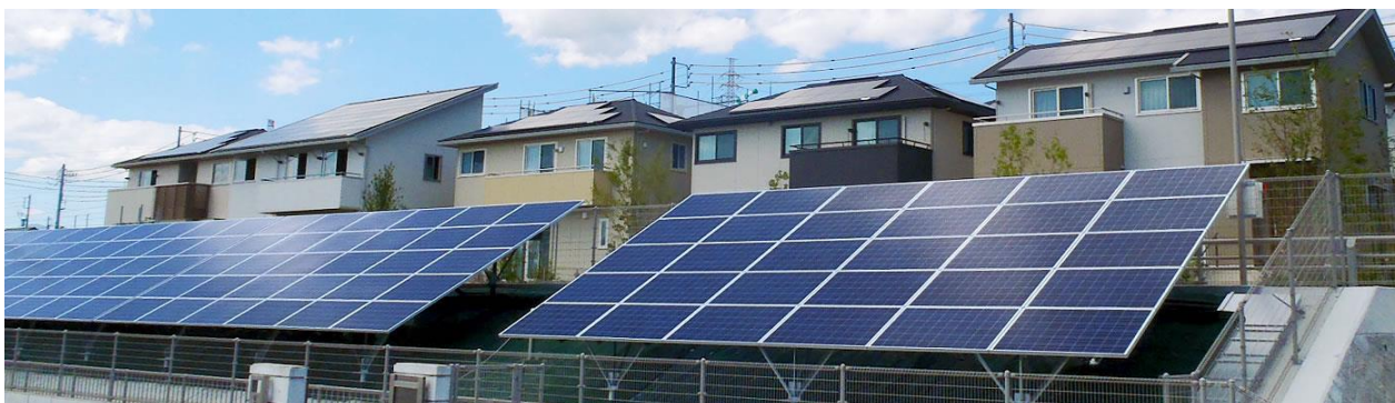
【街の南側斜面に太陽光発電所（100kW）を設置し、ZETを実現した「スマ・エコ タウン陽だまりの丘」】
