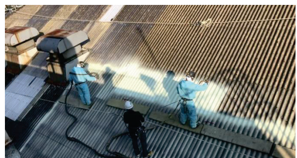
【SOSEI 施工風景】
